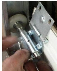
Mise en place de la deuxième partie du porte roulette résidentiel latéral avec une roulette
