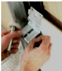
Mise en place de la vis
